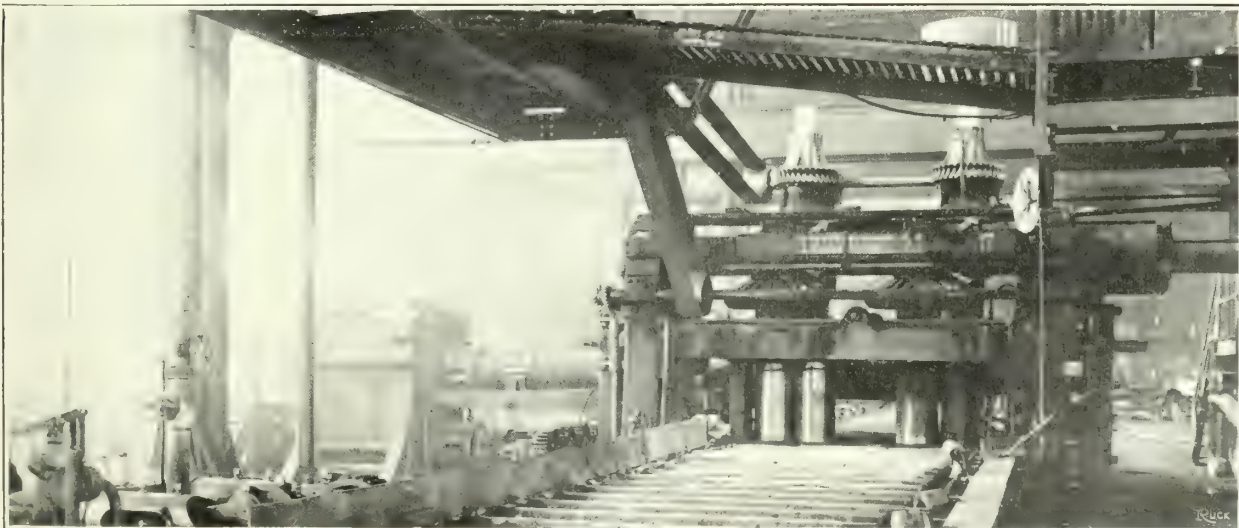
LAMINOIR POUR PLAQUES DE BLINDAGE. — Les grandes plaques de blindage, destinées à la confection des tourelles de cuirassés, sont amincies par un laminoir géant dont les rouleaux ont une puissance formidable.
